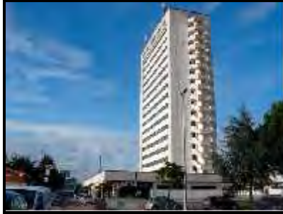
Fig. n.1 Grattacielo di Pomezia 13° Piano Sede Direzionale Soradis S.I.A. Srl
